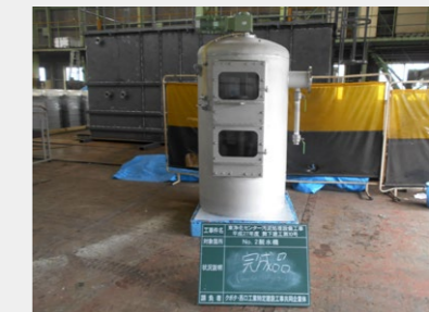
■ 凝集混和タンク
