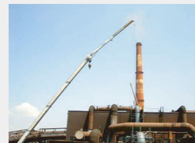
■ 関西熱化学 集塵ダクト工事
