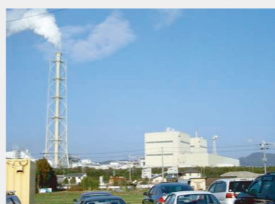
■ 関西電力赤穂発電所 定期点検工事
